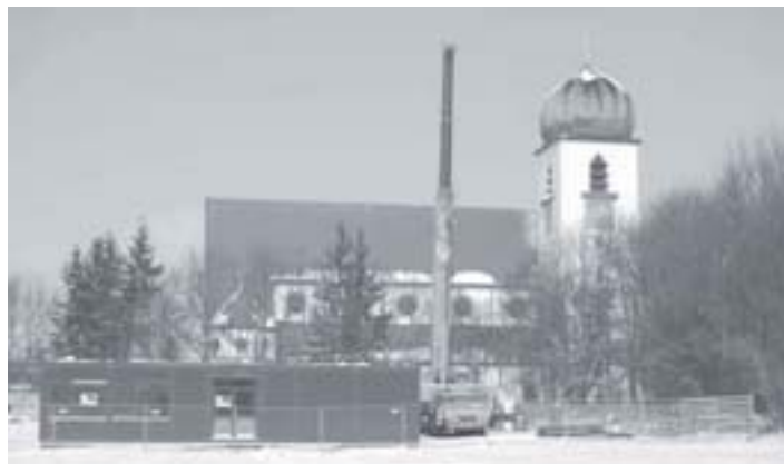
Die ersten Container als Ausweichquartier während des Schulneubaus stehen bereits. Foto: Irina Vogelsgesang
